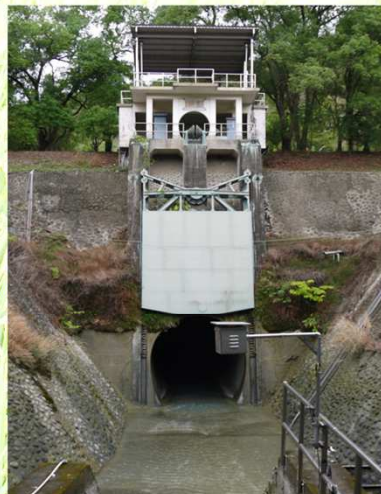
隧道入口(東口取水口)
