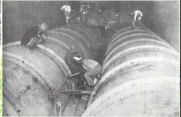
2本の送水鉄管のリベット打ち作業
