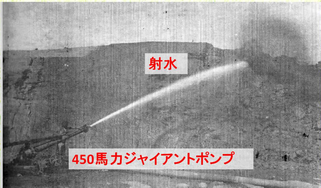
ジャイアントポンプによる水の噴射。1923年5月13日撮影(写真:嘉南農田水利会蔵)
