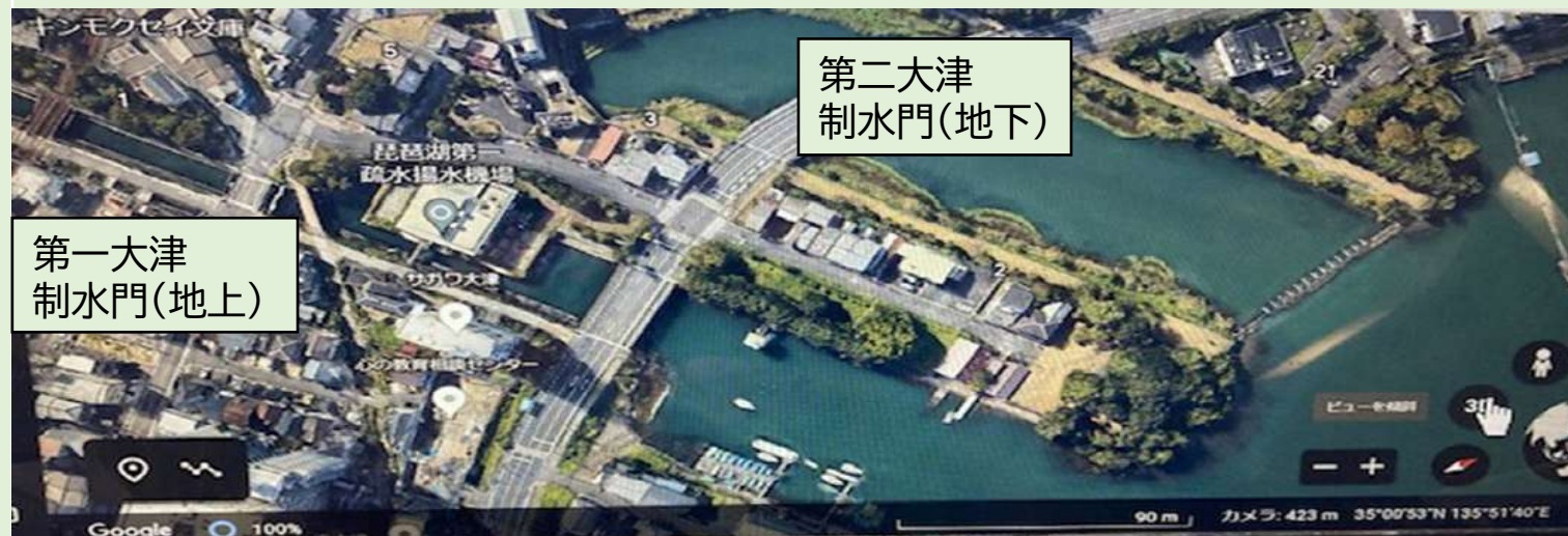
図 14 疏水取水口 大津港
