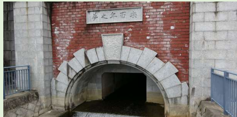
図8 扇ダムから一部南禅寺船溜へと哲学の道に分かれる おもに庭園灌漑の役目
